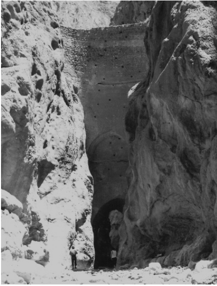
شکل ۴ و ۵: طاق‌بند شاه عباسی (ساخت طاق آجری و قرارگیری سد سنگی بروی آن)
