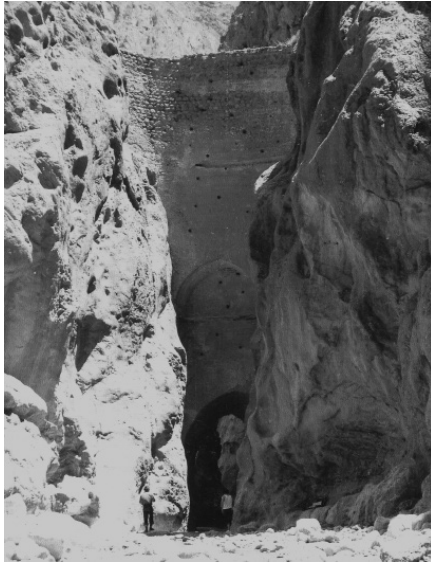
شکل ۴ و ۵: طاق‌بند شاه عباسی (ساخت طاق آجری و قرارگیری سد سنگی بروی آن)
