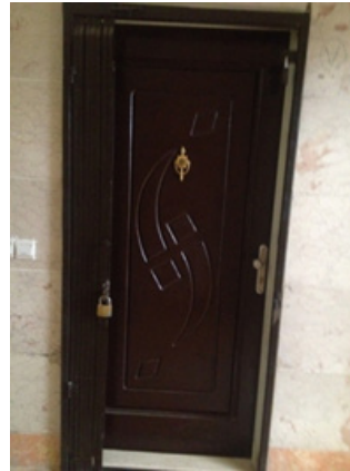
شکل ۸: نصب حفاظ آکاردئونی در درب ورودی
