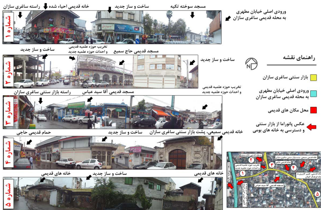
شکل ۴: تحلیل عکس‌های پانوراما از جداره‌های محله قدیمی ساغریسازان و پررنگ شدن ساخت و ساز جدید و بی‌رویه
