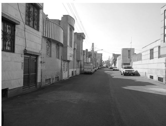
شکل ۵: سیمای کلی خیابان باجک
