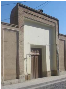
تصویر ۲۱- هماهنگی آجر و کاهگل جداره محور
