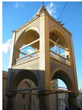
تصویر ۲۰- برج ناقوس با مصالح آجر و کاشی
