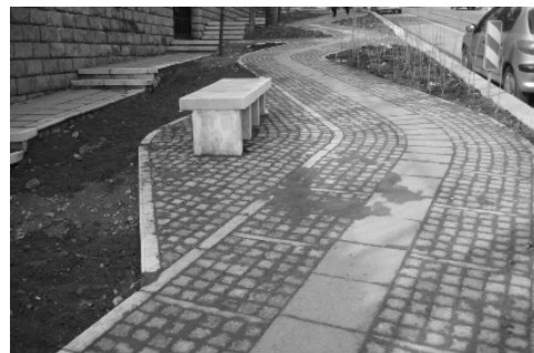
شکل ۱۰: شیب طولی غیراستاندارد و بدون پاگرد شکل ۱۱: عدم تعبیه میله دستگرد در دوطرف مسیر شیب‌دار
