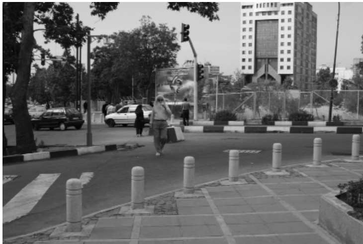
شکل ۹: فاصله کمتر از ۹۰ سانتیمتر بین میله‌های امنیتی
