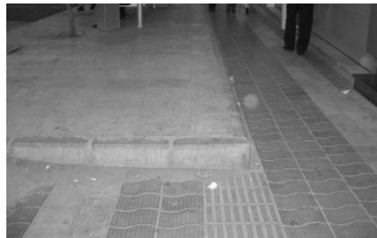
شکل ۲: قطع مسیر ویژه نابینایان در مناسب‌سازی
