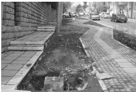
شکل ۱۰: شیب طولی غیراستاندارد و بدون پاگرد شکل ۱۱: عدم تعبیه میله دستگرد در دوطرف مسیر شیب‌دار
