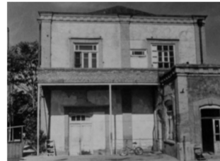
نمای شرقی ساختمان ۱ قبل از مرمت
