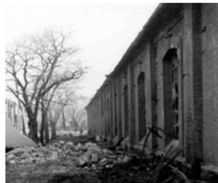
نمای شمالی ساختمان ۳ قبل از مرمت
