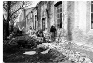
نمای جنوبی ساختمان ۲ قبل از مرمت
