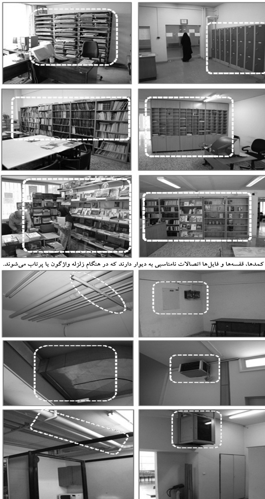
تأسیسات (تابلو برق، لوله‌های آب، کانال کولر، رک کامپیوتر و ...) روکار و غیر استاندارد و آسیب‌پذیر در برابر سانحه
