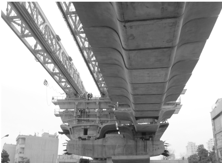
شکل ۲: عملیات نصب دهانه پیش ساخته توسط گنتری در بزرگراه طبقاتی صدر
