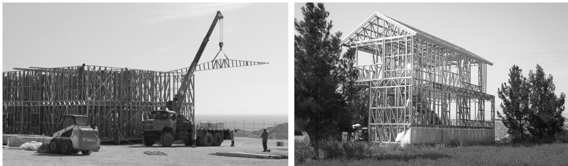
شکل ۳: به‌کارگیری اجزای مدولار و استاندارد در مراحل اولیه طراحی و ساخت و ساز با سیستم LSF
