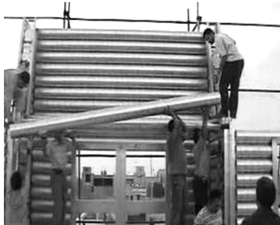
شکل ۵: تولید ضایعات اندک در سیستم ترونکو، ساختمان‌سازی در شهر کاشان
