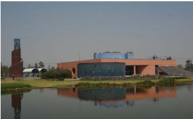
تصویر ۱- دید به مجموعه بنای اکولوژیکی از سمت رودخانه
