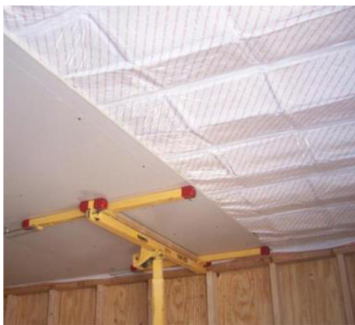
شکل ۲: نصب PCM بر روی سقف مدل
